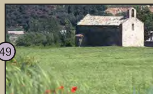
49 Santa Llúcia de Tragó: Templo erigido en el siglo XI en las afueras de la actual población de Tragó, hecho que realiza el conjunto arquitectónico. Presenta una singular capçalera trilobulada.
