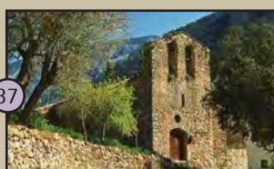
37 Sant Romà de Perles: Iglesia románica construida en el siglo XII con partes añadidas posteriormente. La existencia de una iglesia en Perles se documenta desde el año 1051.
