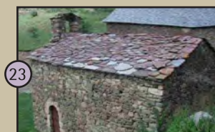
23 Sant Martí de Biscarbó: Pequeña iglesia documentada desde finales del siglo XI. La sencillez y la rusticidad de su construcción recuerda a una tradición constructiva más antigua.
