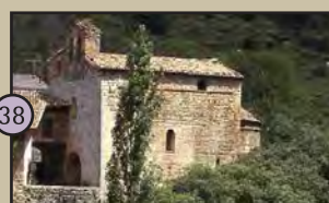
38 Sant Esteve d'Alinyà: Iglesia consagrada en 1057 por el obispo Guillem Guifré de Urgel, y reconstruida a principios del siglo XII con grandes sillares rectangulares.
