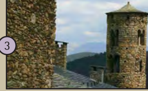
3 Sant Martí d'Ars: Iglesia románica construida en el siglo XI, muy modificada. Conserva el campanario románico de planta circular más majestuoso de Cataluña.
