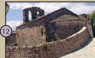
12 Sant Just i Sant Pastor de Cerc Església église construite au XIIe siècle, et dont les divers travaux d'agrandissement à des époques postérieures lui ont donné un aspect cruciforme.
